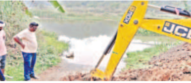
గొలుగొండ, ఫిబ్రవరి 9 ప్రభాతవార్త మండలంలో లింగంపేట వద్ద బుడేరు నదిలో నిర్మించిన భారీ మంచినీటి ప్రాజెక్టుకు సంరక్షించే పనిలో ఆర్డబ్ల్యుఎస్ అధికారులు. 16 పంచాయితీలకు తాగునీరు అందించే ఉద్దేశంతో లింగంపేట వద్ద బుడేరు గడ్డలో భారీ మంచినీటి పథకం నిర్మించారు.
